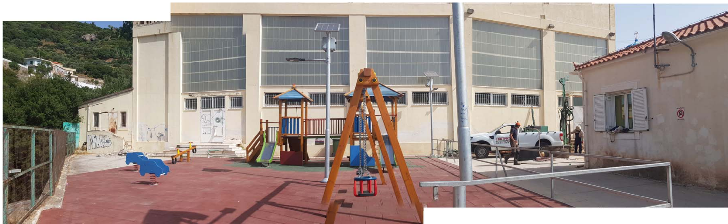
ΦΩΤ. 1α Γενική άποψη του χώρου του έργου από νότια και γεωτρύπανο στη θέση Γ1
