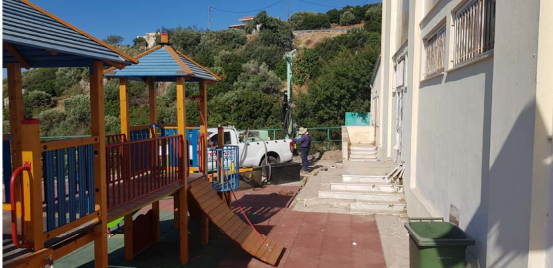
ΦΩΤ. 2 Γεωτρύπανο στη θέση Γ3
