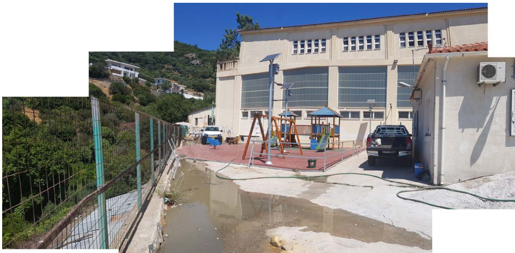
ΦΩΤ. 1γ Γενική άποψη του χώρου του έργου από ΝΑ και γεωτρύπανο στη θέση Γ3
