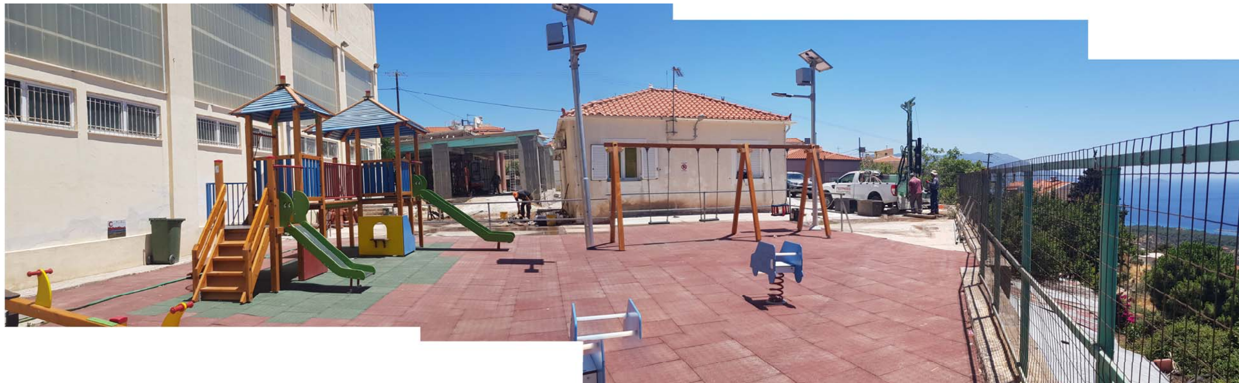
ΦΩΤ. 1β Γενική άποψη του χώρου του έργου από δυτικά και γεωτρύπανο στη θέση Γ2
